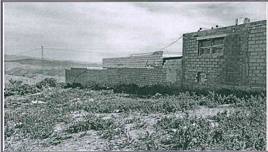
VISTA DESDE EL OESTE
