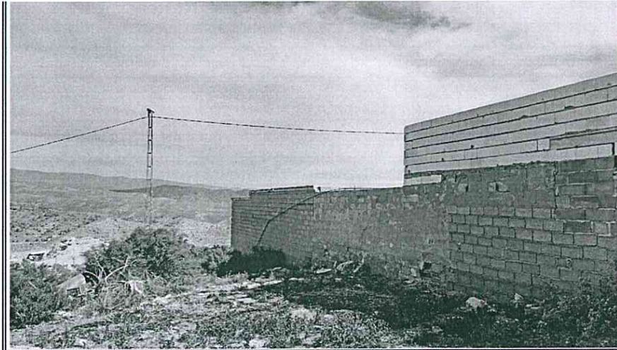
VISTA DE LA ZONA DONDE SE HA REALIZADO EL TECHO
